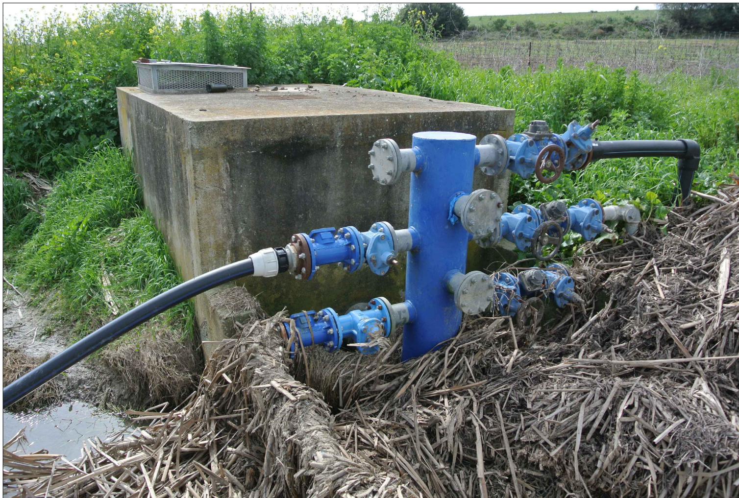
Opera di presa esistente "comizio 102" realizzata in corrispondenza di un pozzetto della condotta adduttrice ENAS
